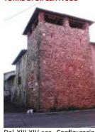
Del XIII-XIV sec. Configurazione strutturale primaria. La torre rimasta ha struttura muraria in ciottoli di fiume disposti a spina di pesce e rafforzati da cantonali in grossi masselli di arenaria.
